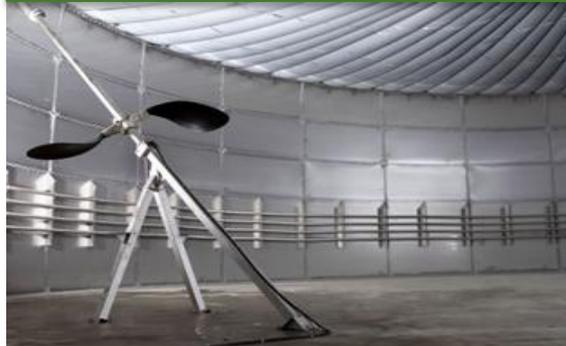
Fermentation à l'intérieur du digesteur des matières organiques sous forme d'un liquide que l'on maintient le plus homogène possible grâce à un brassage. Le digesteur est une cuve (en béton, acier, ou autres matériaux) généralement cylindrique. Il peut être enterré ou hors sol et est hermétiquement clos, isolé, brassé et chauffé.
